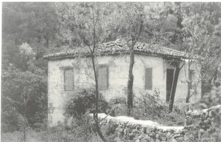
Το σπίτι του Περεσιάδη στο Μεσορρούγι Αχαΐας. (Φωτ. Α.-Φ. Νομικός)
